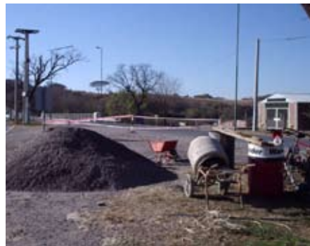
Primeros días de agosto de 2006: comenzaron a acarrear materiales y elementos de trabajo para dar comienzo a la obra.
